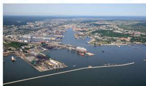
Pogłębianie akwenów wewnętrznych portu
